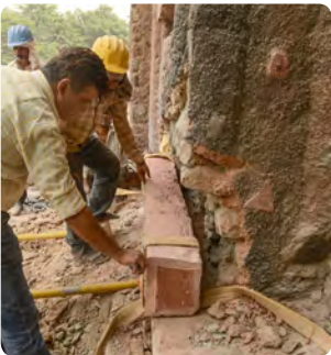
Installing stone jaalis
