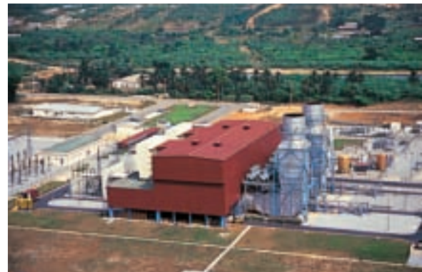
FINANCÉE PAR L'AKFED, LA SOCIÉTÉ HELVÉTIQUE-SUÉDOISE ABB ET ÉLECTRICITÉ DE FRANCE, LA CENTRALE ÉLECTRIQUE D'AZITO A UNE CAPACITÉ DE 288 MÉGAWATTS, SOIT 30% DES BESOINS EN ÉLECTRICITÉ DE LA CÔTE D'IVOIRE.
